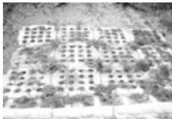
제작된 식생블럭 시제품을 이용한 시험 시공
